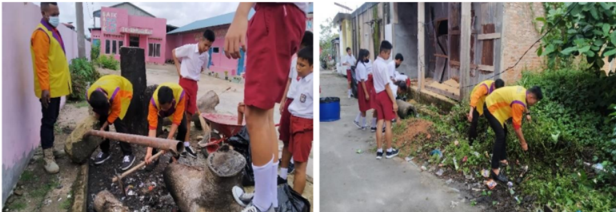
Gambar 1. Kondisi Lingkungan Sekolah SD Pondok Kasih Batam
